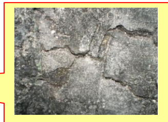
Обвуглювання деревини під покриттям
